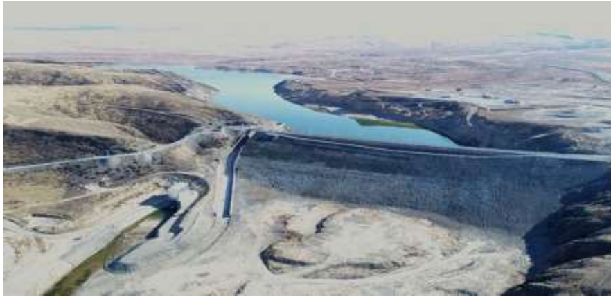
Рисунок 1 — Плотина на реке Кызылагаш
